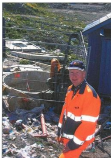
Anleggsingeniør Øystein Olimb foran den 22 meter dype kummen inne på deponiet
