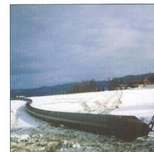
Bildet: Som en ål lå det ferdig sveisede PE-røret i 225 meters lengde.
