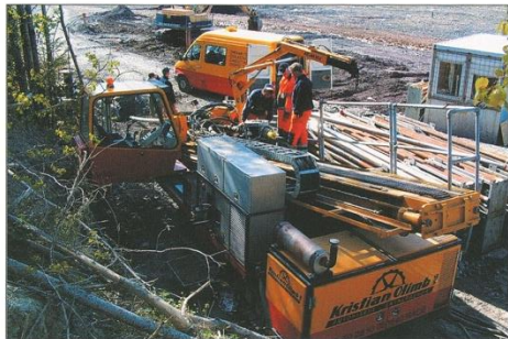
Klart for styrt boring i 540 meters lengde på Bøler Avfalls-deponi Skedsmo kommune
