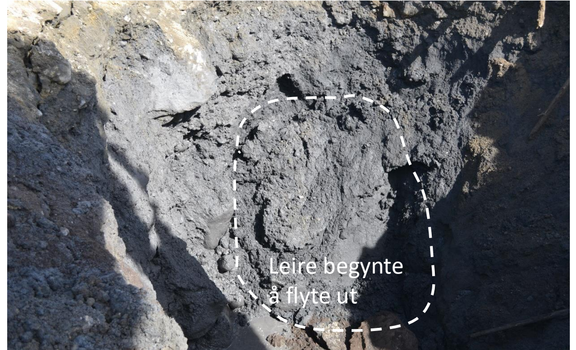
Moreneleira gikk fra fast til flytende velling på kort tid, og store mengde leire fløt ut
